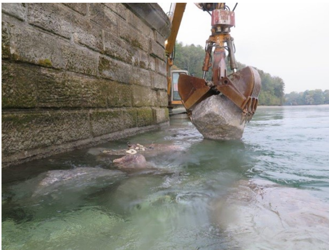
Herbst 2016: Einbringen des Blockwurfs beim Pfeiler 3 (Kolkchutz) (alle Fotos: Christoph Brändli)
