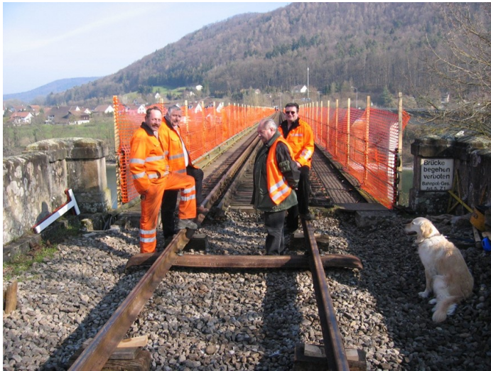
9. März 2007: Baustellenbesichtigung beim Schwelleneinbau
