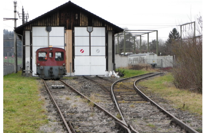
Bild: 2 : Umgeschwenkte Gleisführung zum SBB- Unterwerk
