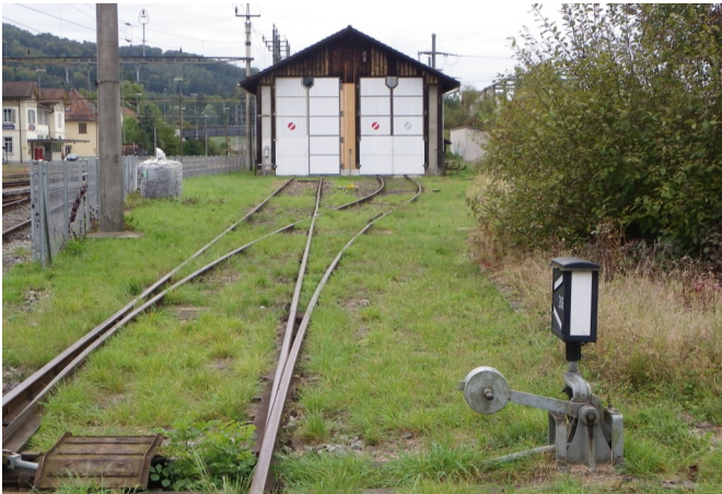
Bild 1: Zufahrtsgleise zur Remise im Normalzustand
